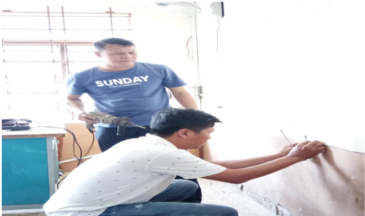
Thầy Hưng – PHT và GV nam sửa chữa CSVC chuẩn bị đón học sinh trở lại học sau thời gian tạm nghỉ do dịch viêm đường hô hấp cấp corona
